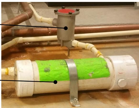
**Figure 7.7-2 : Piège à condensat et neutralisateur**
